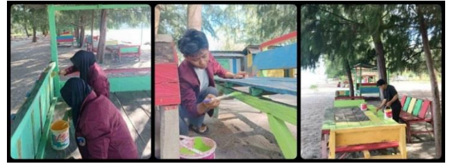
Gambar 2. Pengecatan bangku dan dinding gazebo
